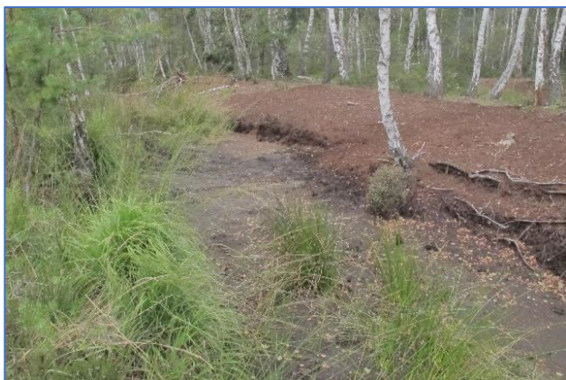
Foto 11: Detail částečně zazemněného odvodňovacího kanálu dokládá jeho funkci. V pravé části odvodnění a oslunění plochy prakticky znemožňuje existenci mechového a bylinného patra vegetace. V levé části snímku, v zastínění, se uchycují trsy bezkolence modrého, které dokládají kolísání hladiny podzemní vody.
