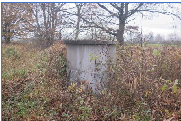
Foto 2: Ochranná skruž vrtu MH-26. V místě bude vybudován zděný objekt o zastavěné ploše cca 11 m 2 s oplocením a příjezdovou cestou (SO-02). Plocha je porostlá ruderální vegetací s převládající chrasticí rákosovitou a kopřivou dvoudomou, objevují se exempláře různých druhů křovinných vrb.
