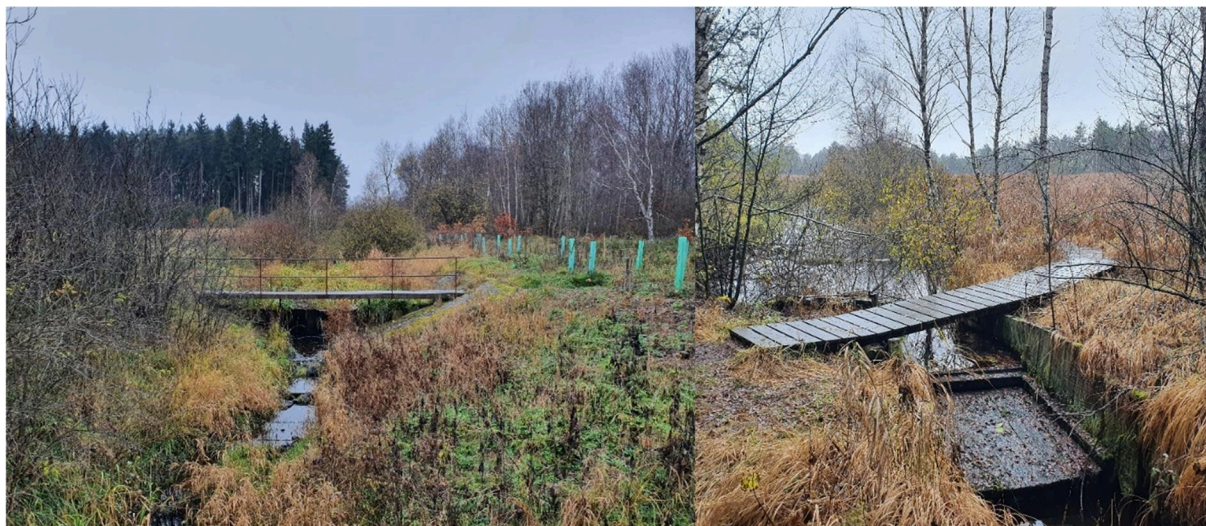
Obr. 3 Vlevo přehrazení Blatské stoky před zavlažovacím jezerem a vpravo přehrazení odvodňovacího kanálu za rašelinným jezírkem
